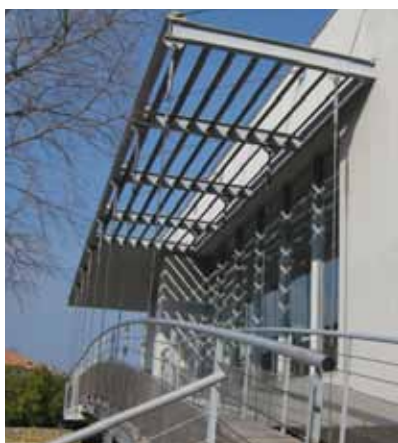
Cornillon : Construction et équipement de la médiathèque
